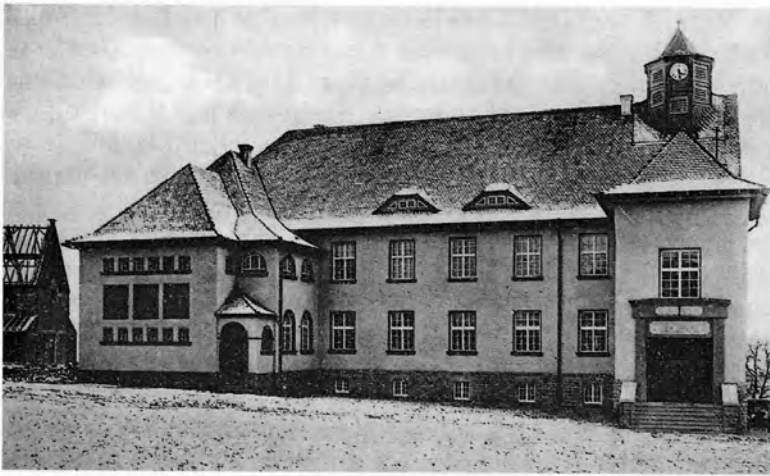
Schillerschule 1926, unmittelbar nach dem Neubau. Im Hintergrund links ist der Rohbau der Pfarrkirche St. Josef zu sehen.
